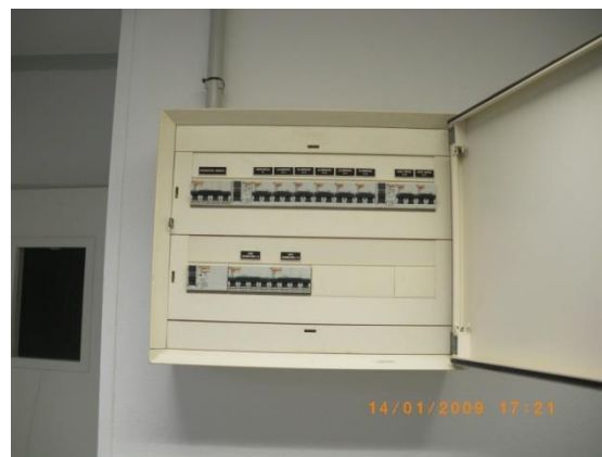
Detalle de Cuadro Secundario de Módulo Prefabricado
