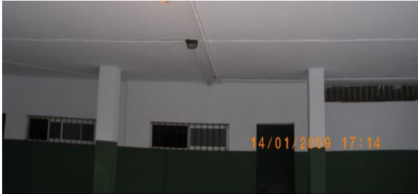
Ventanas Aseos Planta Baja
