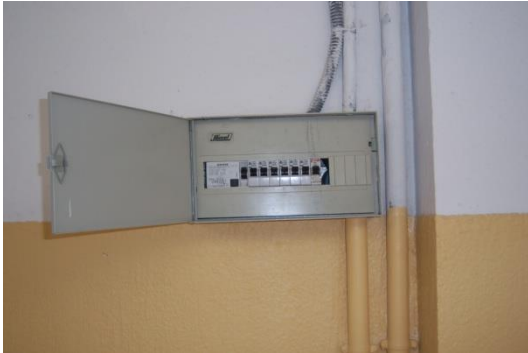
Detalle de Cuadro Secundario Planta Segunda
