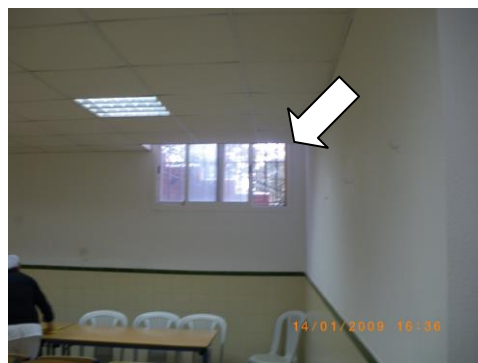
Ventana Comedor Fachada Este
