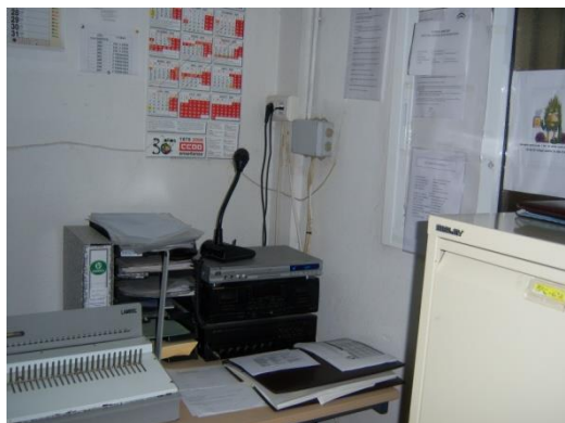
Detalle del equipo de megafonía (ver actualización 2020- 2021)
